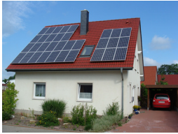
Abbildung 0.1: Mit einer solchen Photovoltaik-Anlage auf dem Dach lassen sich drei Haushalte mit Strom versorgen.
