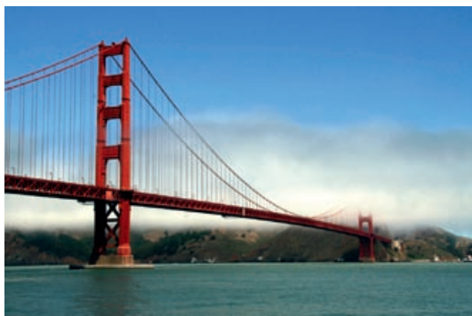
Abbildung 3.01: Die DAC09 konnte erfolgreich die aktuelle Wirtschaftskrise überbrücken, aber wie bei der Golden Gate Bridge bleibt auch einiges noch im Nebel verborgen.
